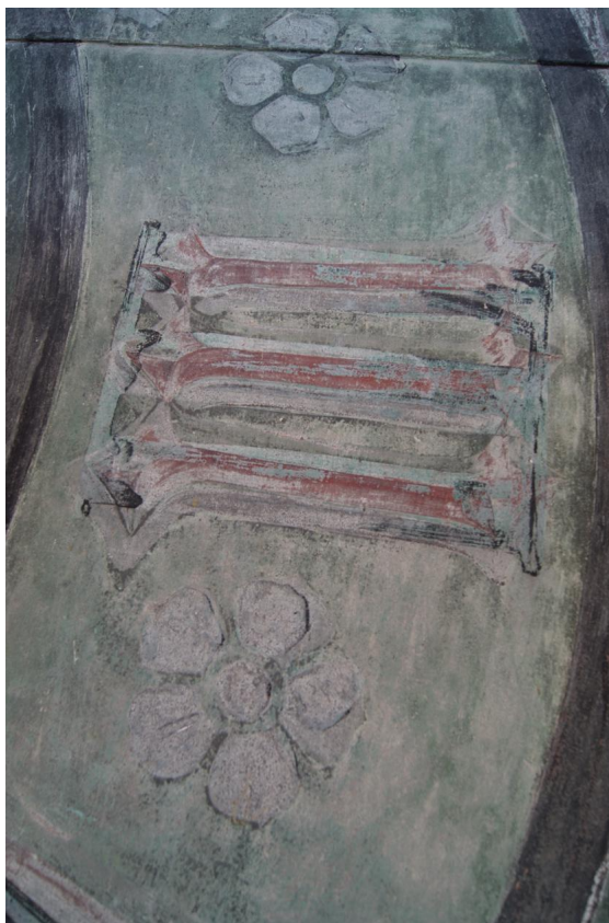
Fot.8 Widoczne dwie warstwy cyfr, oryginalna i przemalowanie
