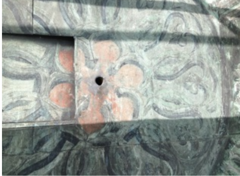
Fot.5 Partia centralna zegara, wskazówki zdemontowane
